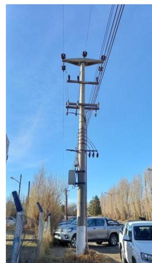
Figura 82 -Visita a la usina de generación en lago Posadas, punto de conexión a la línea urbana en 13.2 kV
