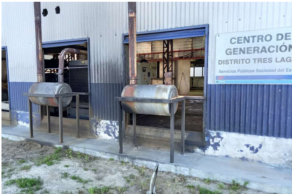
Figura 81 Centro de generación diesel en Tres Lagos (Viaje #4 – 31/10/2023)
