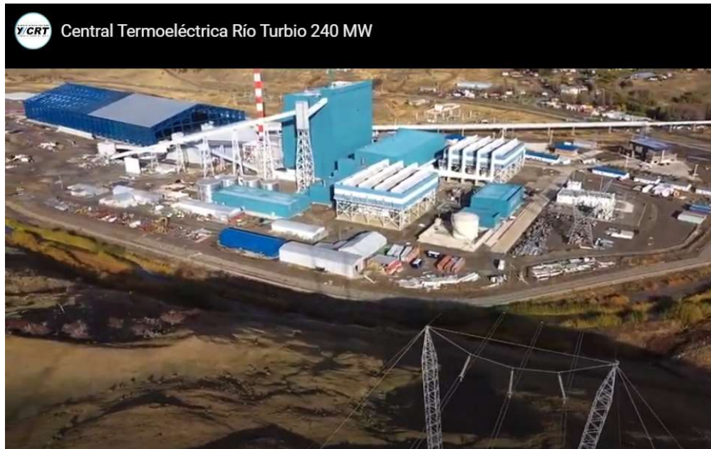
Figura 61 CTRTR – vista aérea y conexión al SADI en 220 kV [YCRT,2023]
