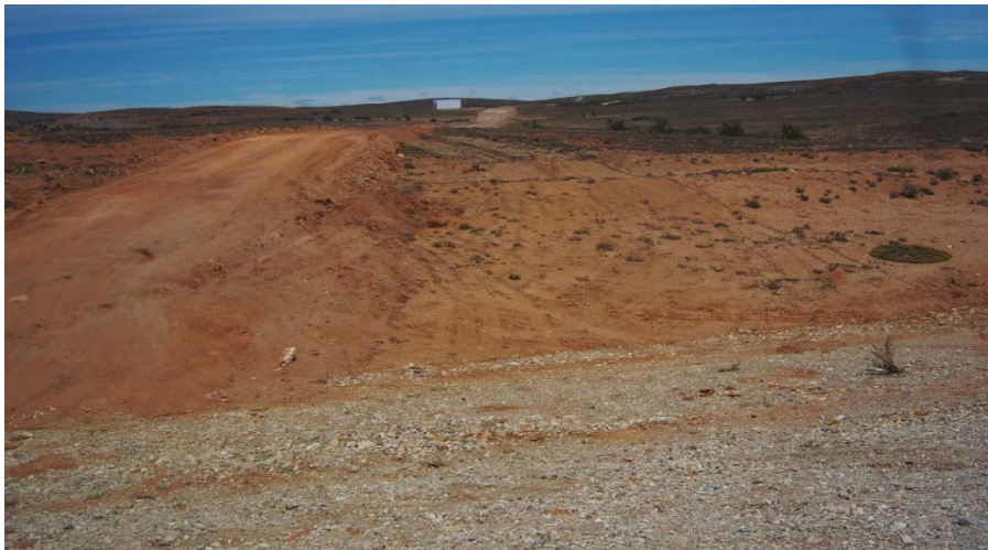
Foto 3.1-2. Vista del nuevo acceso al sector La Paloma desde la Ruta Provincial N° 49. Se puede observar el contenedor en que va a funcionar la futura garita de control de acceso.
