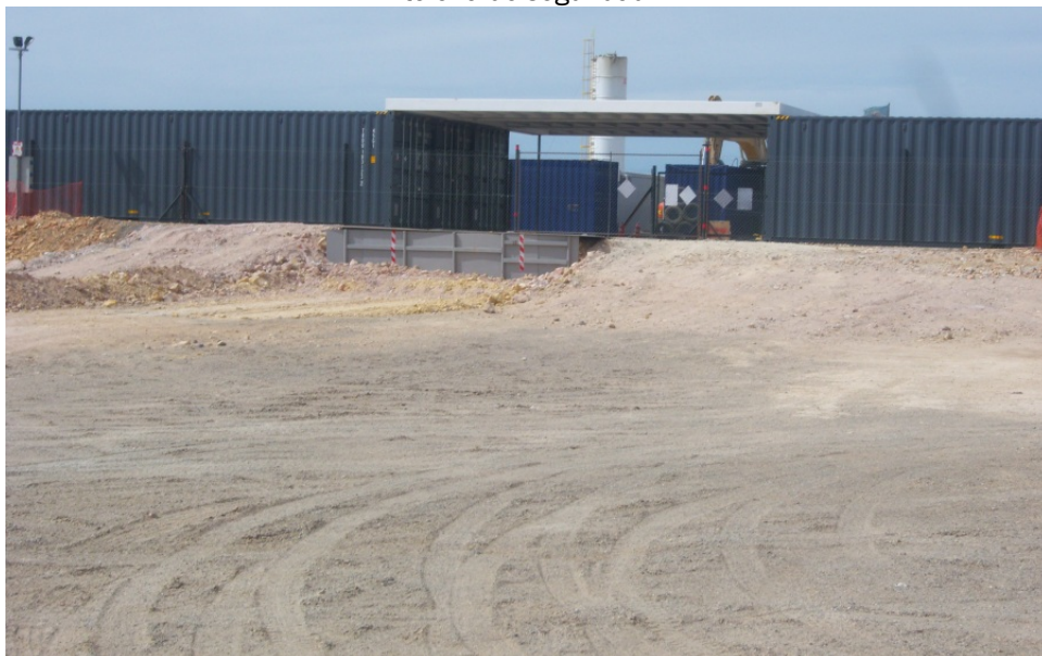
Foto 4.15-5. Vista del sector Sur del Depósito. Se observa la plataforma para que atraquen los camiones, facilitando el acceso de los autoelevadores que se encargan del movimiento de los bolsones a los mismos.
