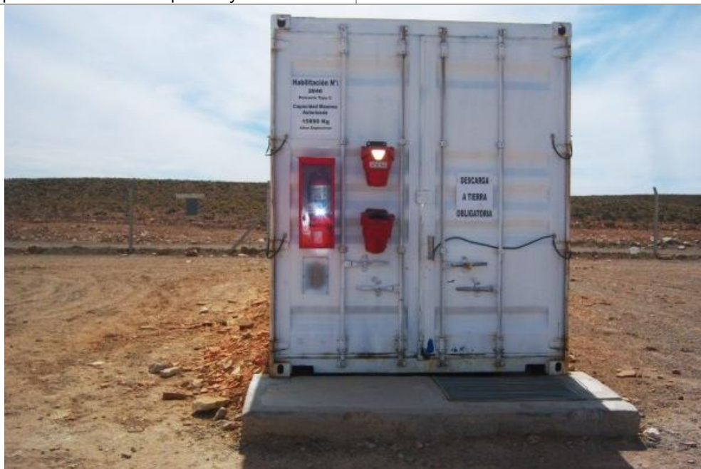
Foto 4.15-3. Vista del frente de uno de los contenedores del polvorín. Se observa habilitación RENAR, matafuegos y cartelería de seguridad.
