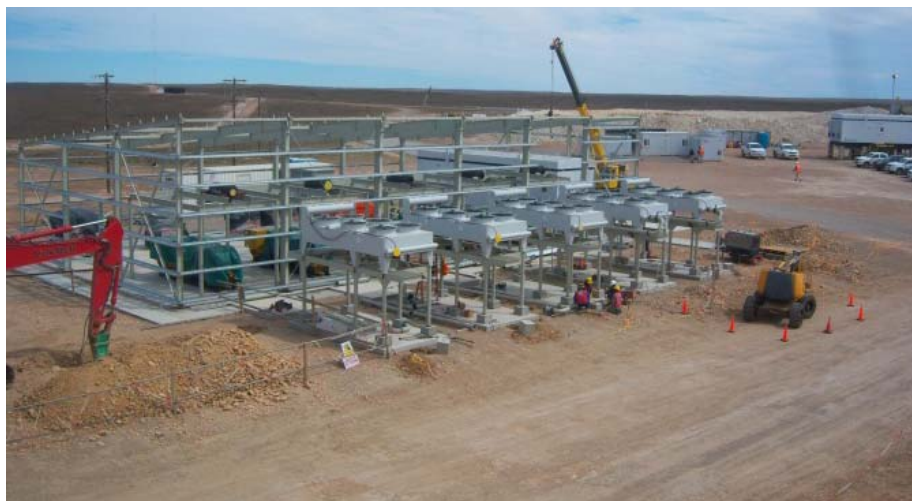
Foto 4.15-18. Vista de la construcción la Planta Generadora.
