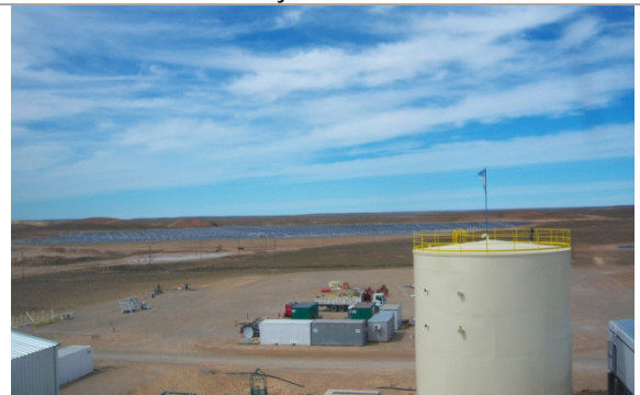
Foto 4.6-9. Tanque de agua fresca y, al fondo, el dique de colas.
