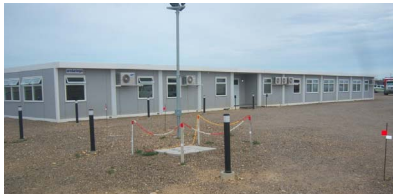
Foto 4.15-6. Campamento. Sector Oficinas y SUM.
