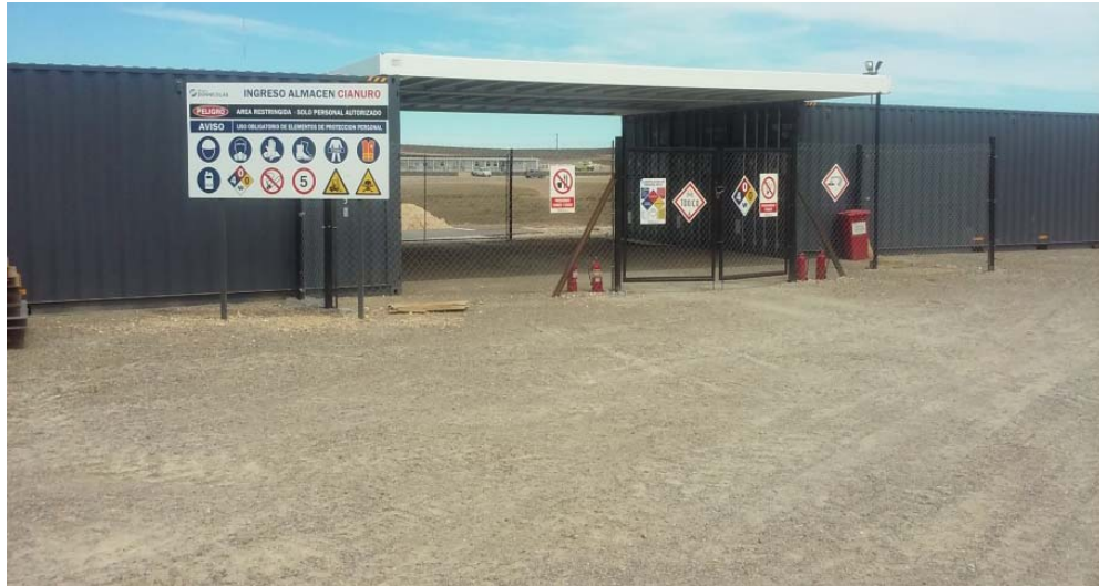
Foto 4.15-4. Vista del frente del Depósito de Cianuro. Se observa cierre perimetral del acceso, matafuegos y cartería de seguridad.
