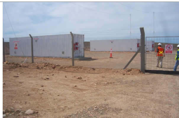
Foto 4.15-2. Vista del cercado perimetral del polvorín.
