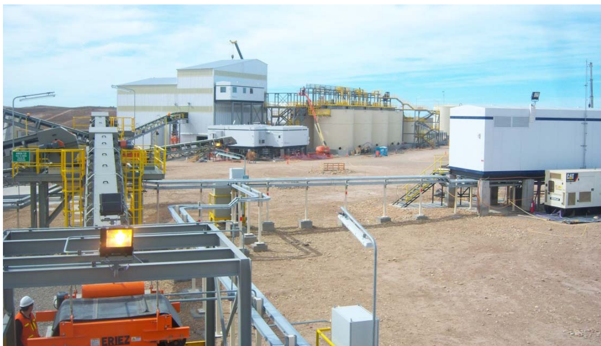
Foto 4.6-1. Vista general de la planta de trituración y la planta de procesos, en su estado de construcción a diciembre de 2016.
