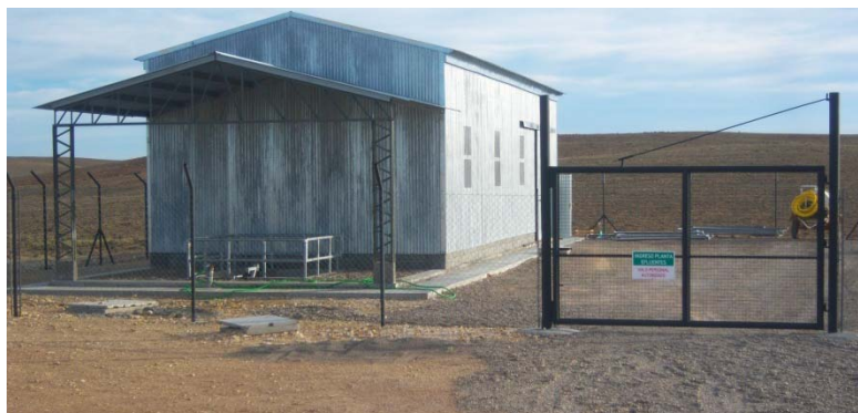
Foto 4.15-9. Planta de tratamiento de efluentes (PTE) con su correspondiente cerco perimetral.
