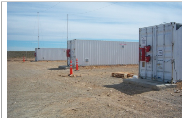
Foto 4.15-1. Vista de los contenedores del polvorín, se pueden observar los pararrayos.
