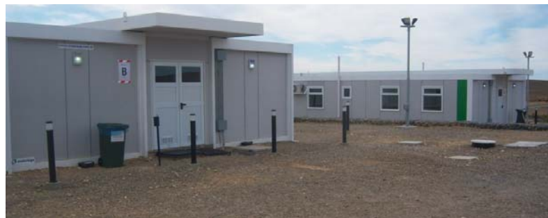
Foto 4.15-7. Campamento. Módulos habitacionales.
