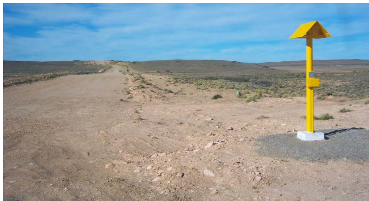
Foto 4.22-2 Traza del gasoducto con la picada y señalizada
