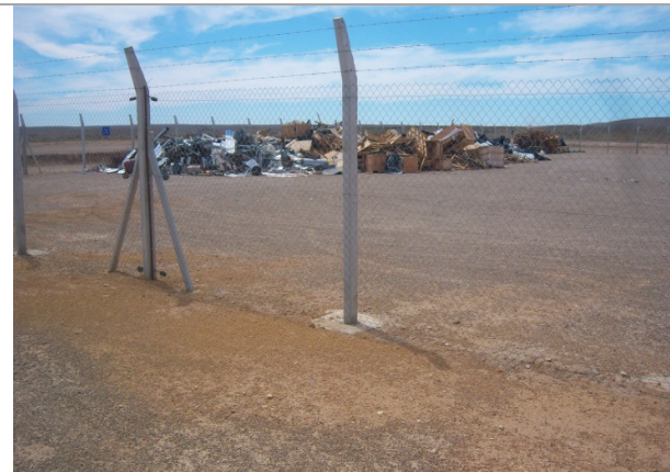
Foto 4.15-16. Vista general del sector de residuos re-utilizables.
