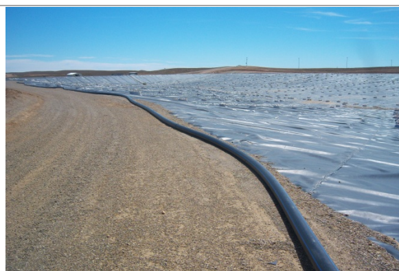
Foto 4.12-10. Recorrido de la tubería sobre el lateral del dique.
