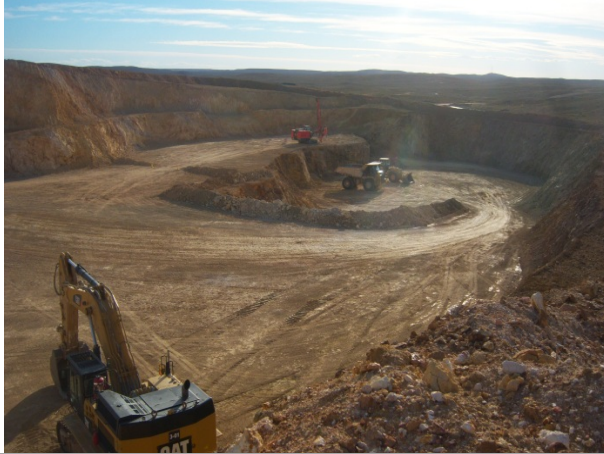
Foto 4.5-1. Vista general del pit. Se observan las máquinas de perforación, retroexcavadoras y camiones de carga.
