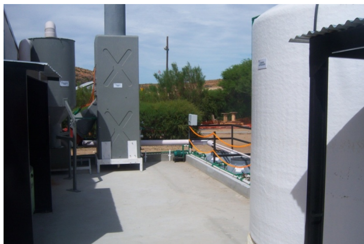
Foto 4.9-1. Sector externo del laboratorio donde pueden observarse el sistema de tratamiento de efluentes líquidos y el lavador de gases.
