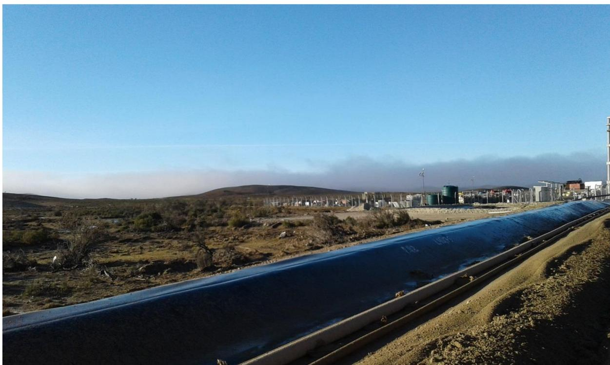
**Fotografía 10. Ducto de efluentes de Planta de proceso a dique de colas.**
