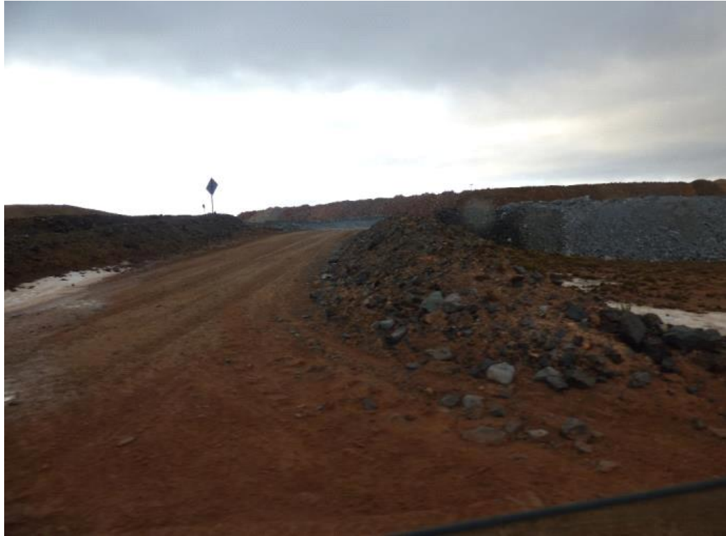
Fotografías 23.1. Escombrera de Mina Subterránea Escondida Far West
