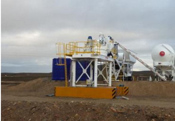
Fotografía 16.9. Operación subterránea en Far West - Planta de Backfill
