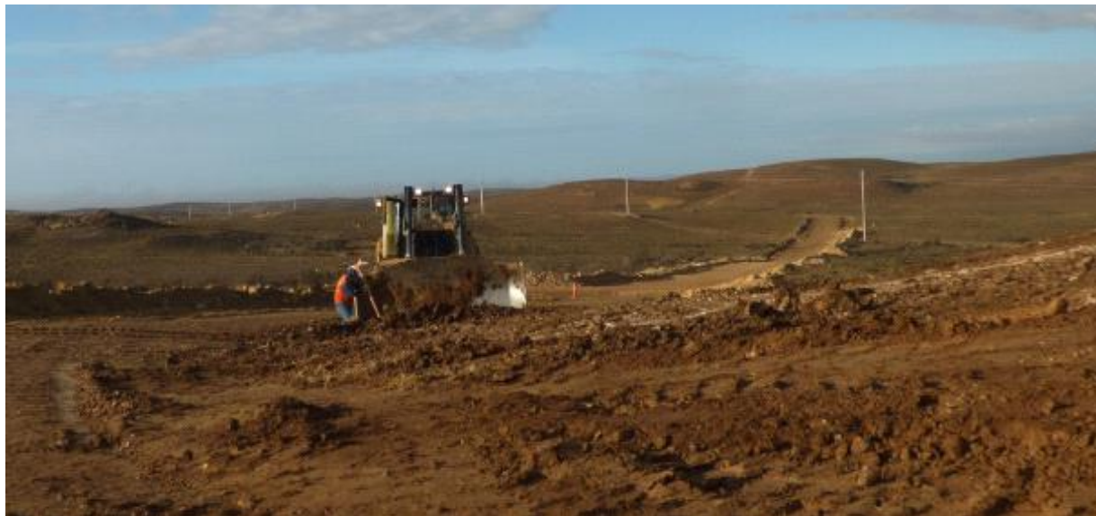
Fotografía 23.3. Escombrera de mina a cielo abierto Carla (Preparación de terreno)
