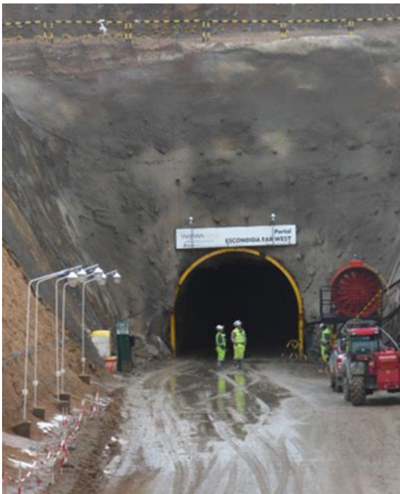
Fotografía 16.11. Operación subterránea en Far West - Portal de ingreso
