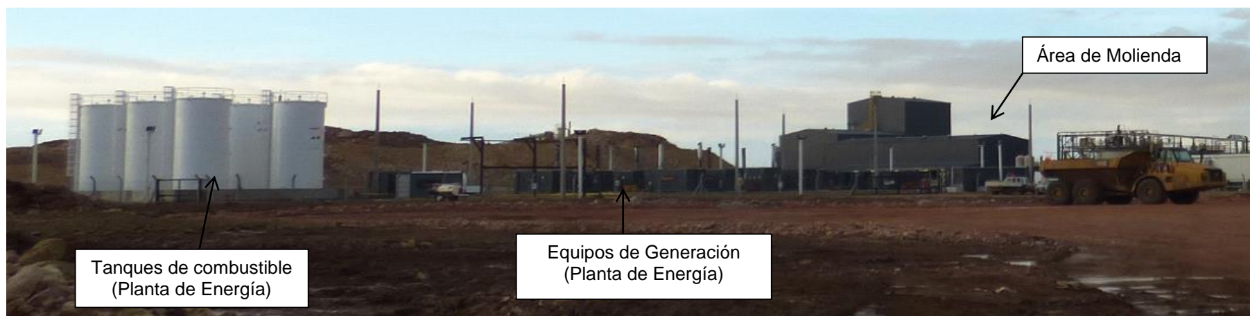
Fotografías 17.10. y 17.11. Instalaciones de Planta de Proceso
