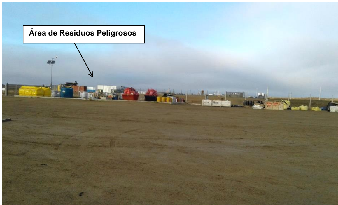
Fotografía 26.11. Patio de residuos
