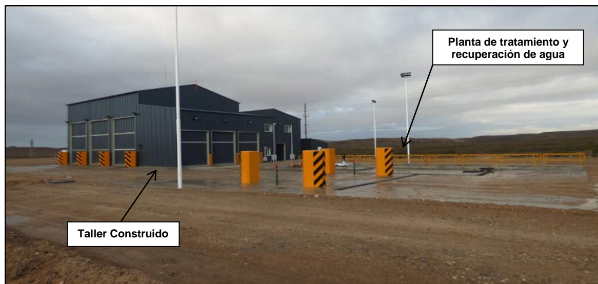
Fotografía 26.16. Mantenimiento mecánico. Área de Mina
