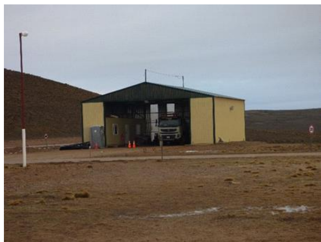
Fotografía 26.2. Instalaciones Brigada de Emergencias
