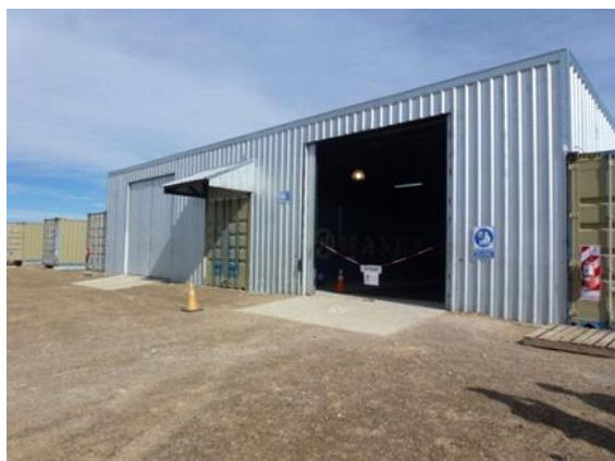
Fotografía 26.14. Mantenimiento eléctrico. Área de Mina – Taller
