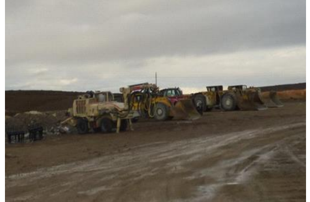
Fotografía 16.10. Operación subterránea en Far West
