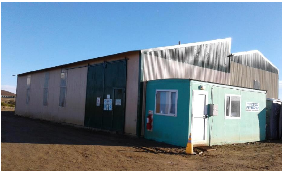
Fotografía 26.5. Planta de tratamiento de efluentes de campamento
