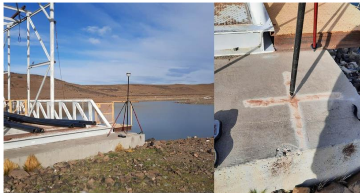
Figura 6.11 Punto de referencia topográfico en la boca de toma del reservorio LG4.
