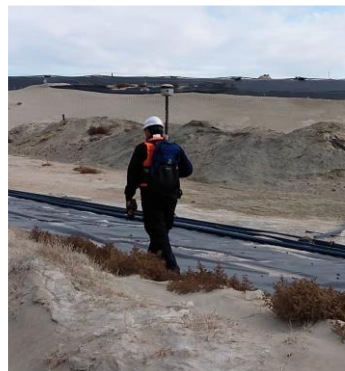
Fotografía 30. Levantamiento dique de cianuración - Revancha
