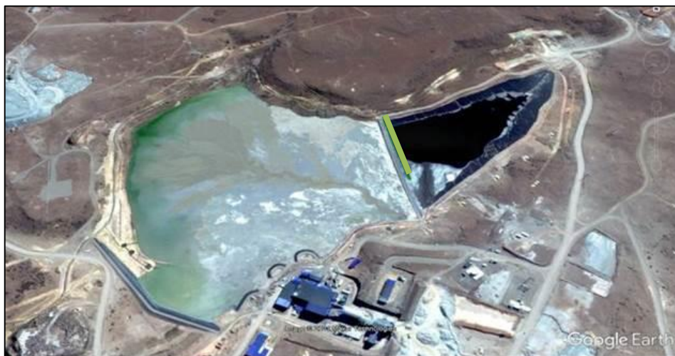
Figura 9.9 Puntos de Talud relevados, línea verde.
