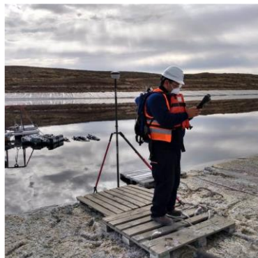
Fotografía 29. Levantamiento dique de cianuración - Revancha.
