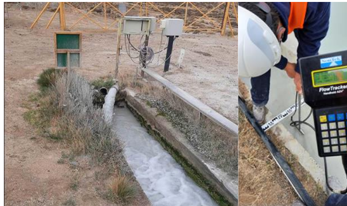
Figura 6.6 Sección aforada y procedimiento de aforo a la salida de la Bocamina Frea.
