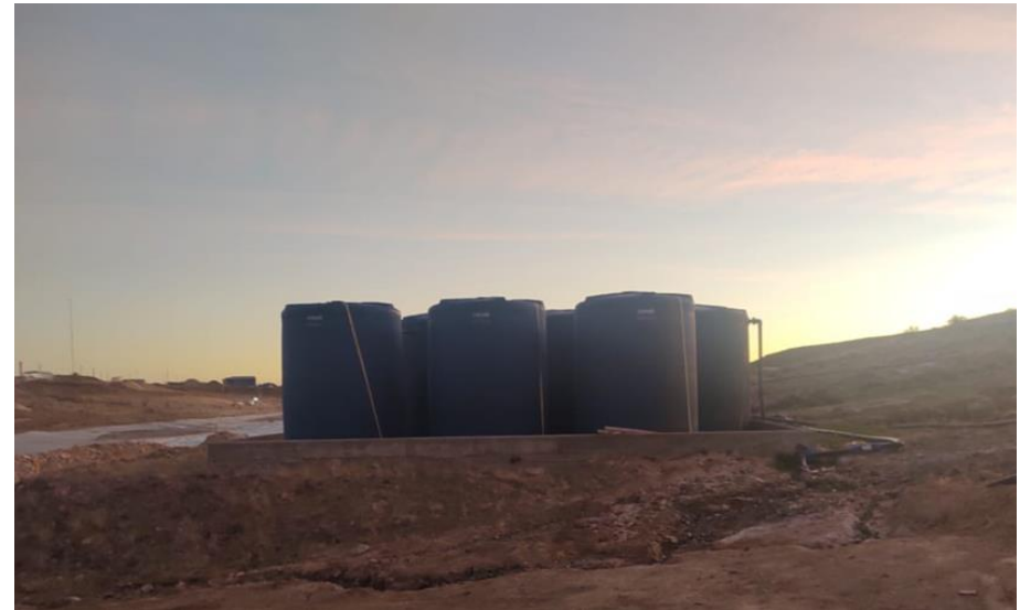
Instalación de tanques de agua para perforación.
