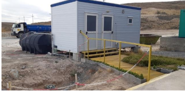
Colocación de baño en PRH con tanque biodigestor
