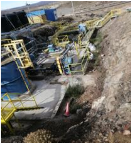
Colocación de pasarelas y corta viento en PRH
