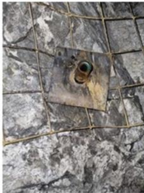
Perno swellex instalado.
