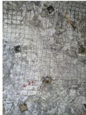
Pernos correctamente instalados con malla.
