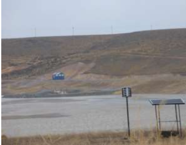
Fotografía 19: Detalle de ahuyentador de aves en el depósito de colas de flotación N°2
