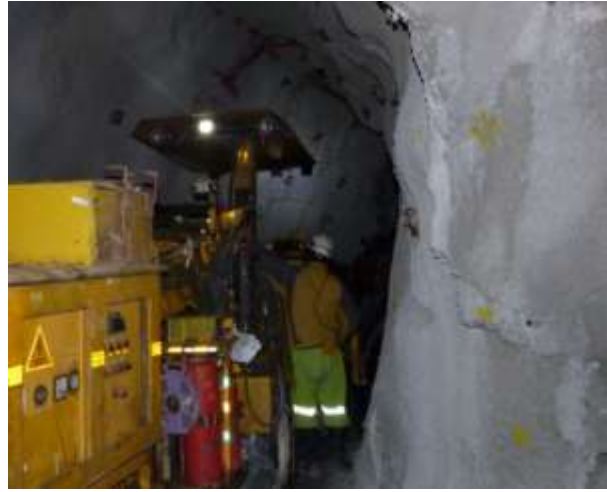
Fotografía 2: Labores de sostenimiento en mina subterránea
