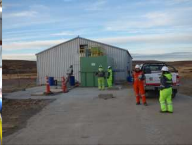
Fotografía 32: Vista general del área de tratamiento de efluentes
