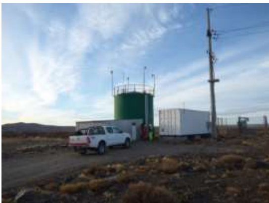
Fotografía 44: Tanque de captación de agua (Tanque Verde)
