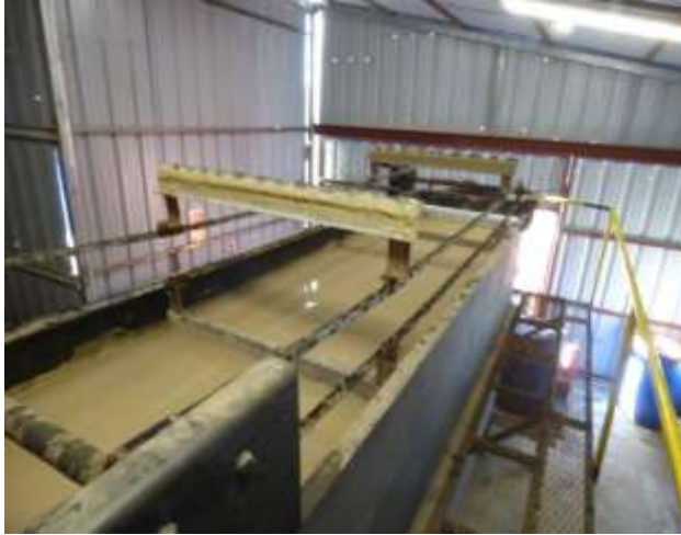
Fotografía 31: Detalle de la trampa de grasas
