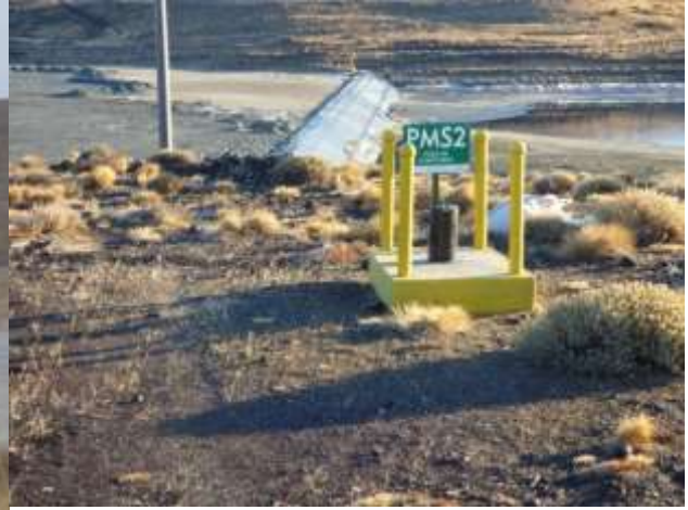
Fotografía 20: Detalle del muro que divide el depósito de colas de flotación y cianuración
