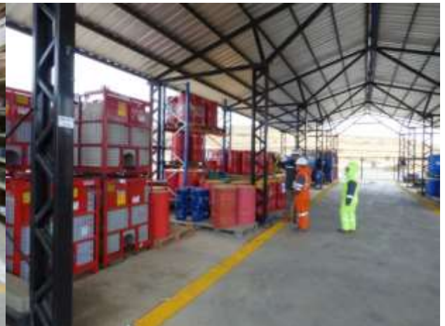
Fotografía 22: Detalle del almacén de insumos peligrosos recientemente cubierto
