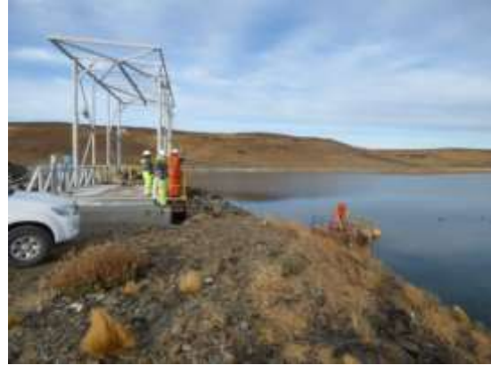
Foto 43: Laguna de evaporación y recirculación de agua industrial Laguna N° 4
