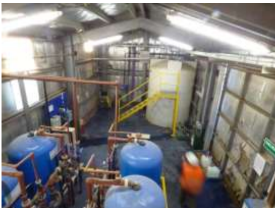
Foto 46: Detalle interior de la planta potabilizadora
