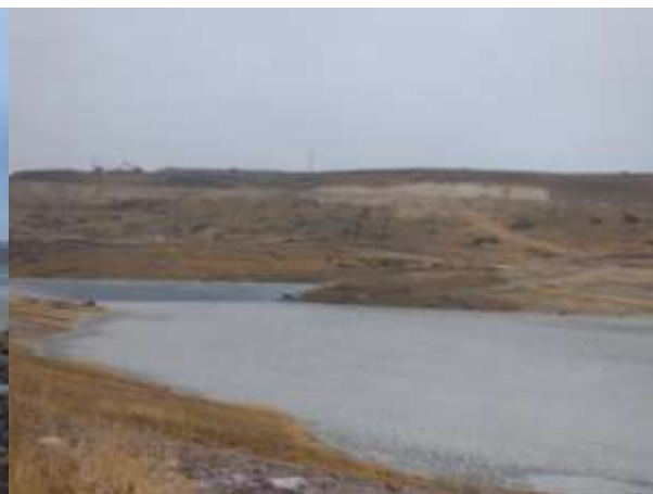
Fotografía 18: Vista del depósito de colas de flotación N°2
