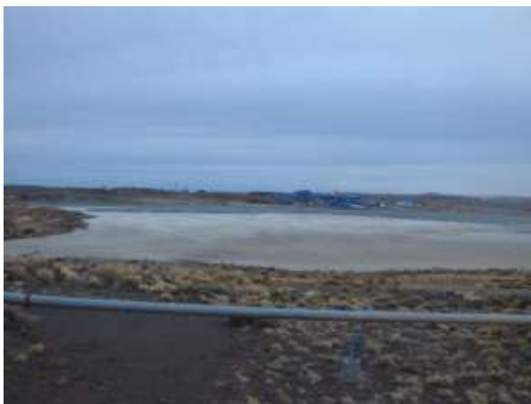
Fotografía 17: Vista del depósito de colas de flotación N°1
