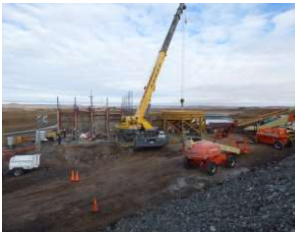
Fotografía 23: Construcción de la Planta de Relleno Hidráulico
