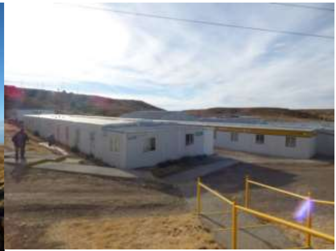
Fotografía 28: Detalle de los módulos habitacionales del campamento
