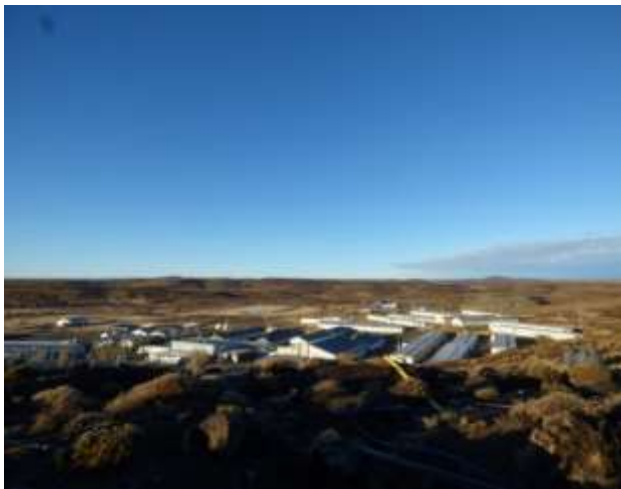
Fotografía 27: Vista del campamento
