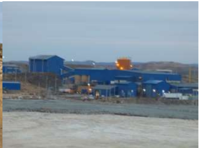
Fotografía 12: Vista general de la planta de proceso UMSJ y en primer plano el depósito de colas de flotación N°1
