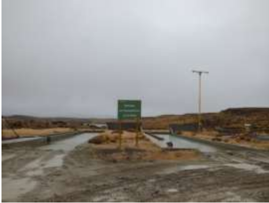
Fotografía 42: Área de tratamiento de agua, poza de sedimentación mina Kospi
