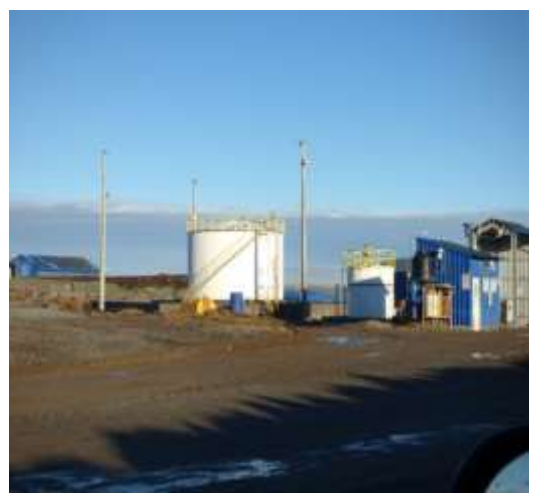
Fotografía 40: Vista del tanque de combustible
