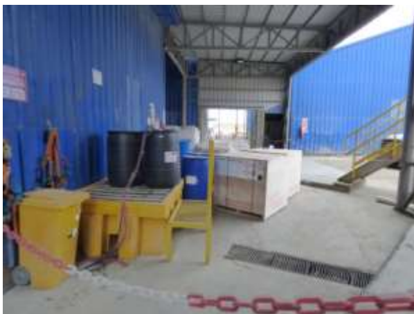
Fotografía 15: Detalle del alero de la planta donde se ubican insumos del proceso
