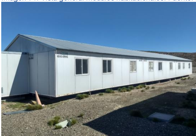
Imagen 72. Módulo de 15 habitaciones. Fuente: MDN S.A.
