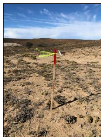
Fotografía 5.2. Estacas de ubicación
