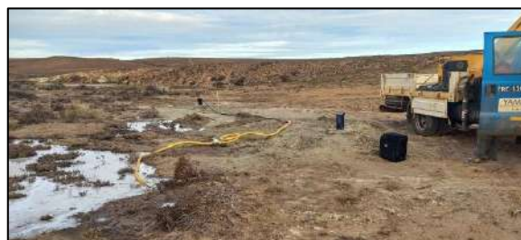
Fotografía 5.8. Bombeo de pozo previo a toma de muestras.
