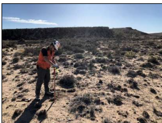
Fotografía 5.1. Colocación de estacas.
