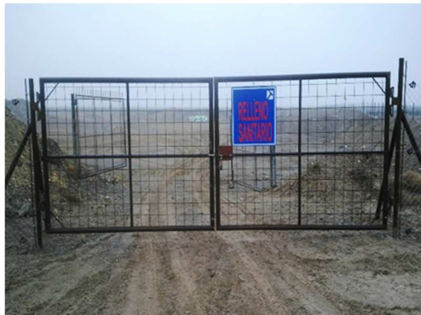
Foto 10 Vistas del Depósito de residuos sólidos urbanos
