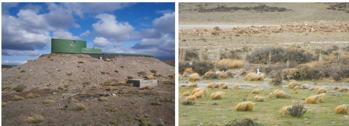
Foto 4. Vista hacia PTE y descarga de agua tratada.
